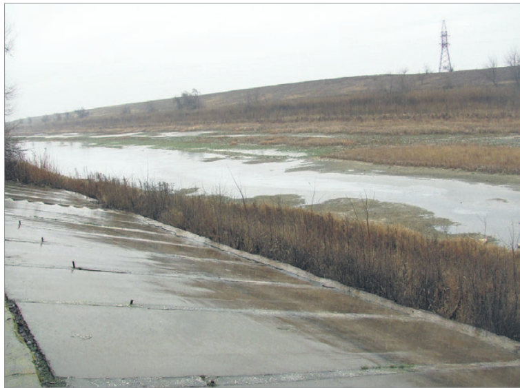
В канале только дождевая вода, да и ЛЭП тоже не работает — взорвана на Украине
